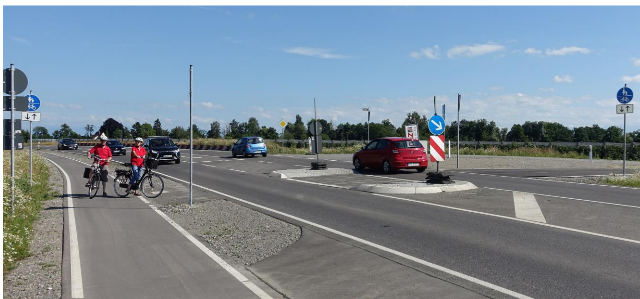
Querungsinsel B 31, Zubringer zum Anschluss Fischbach West, Zufahrt Grenzhof (rechts)
