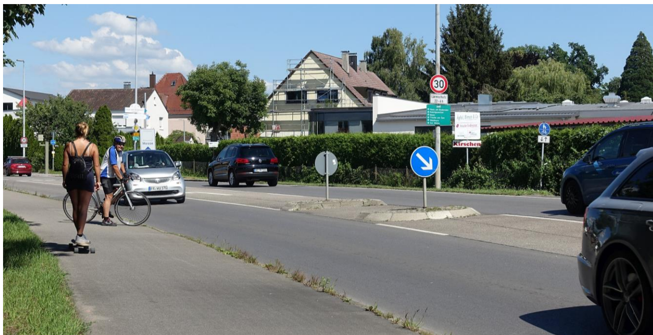
Querungsinsel B 31 Meersburger Straße, zwischen Einmündung Steinäcker und Campingplatz
