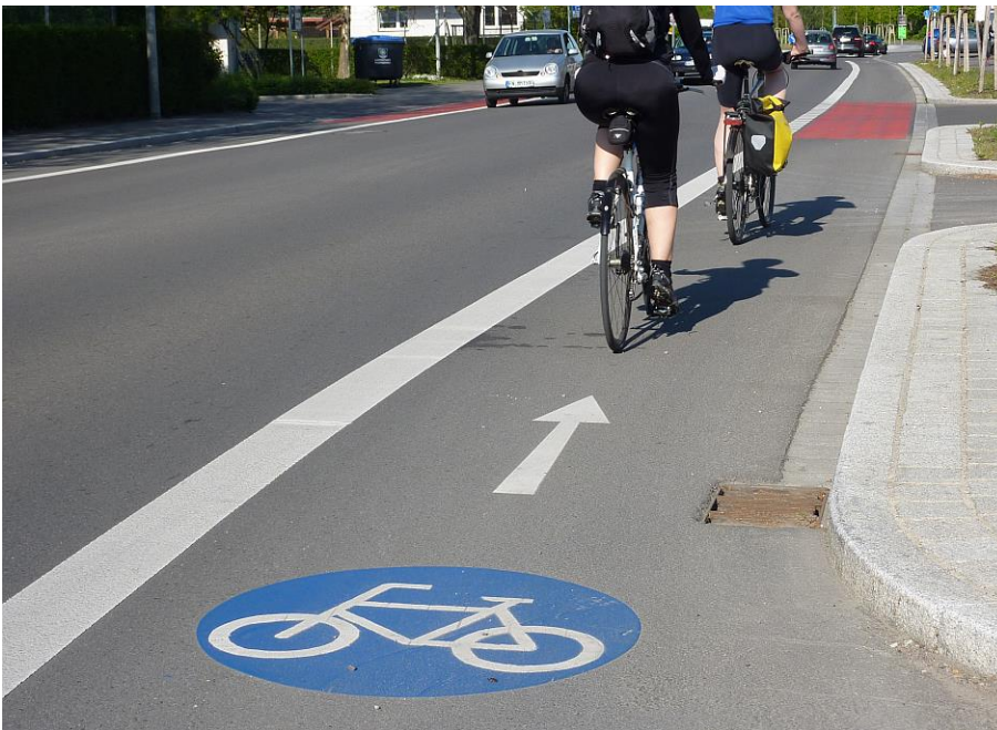
Radfahrstreifen (Beispiel Ehlersstraße Friedrichshafen)
