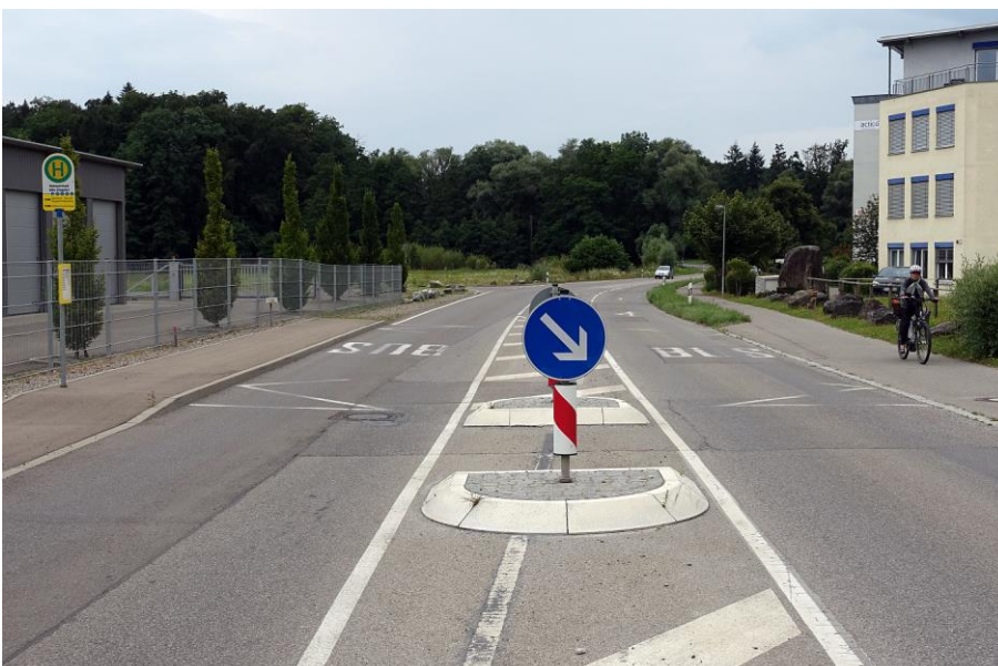
Bus-Cap auf der Fahrbahn mit Querungsinsel (Beispiel L 207 Alte Ziegelei Immenstaad)
