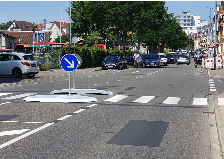
Temporäre Querungsinsel für den Fußverkehr (Beispiel Eugenstraße Friedrichshafen)
