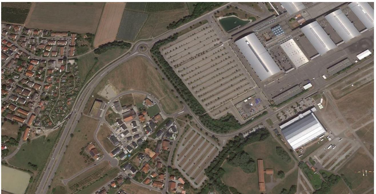
Ebenerdige Parkierungen an der Messe (Google-Luftbild)
