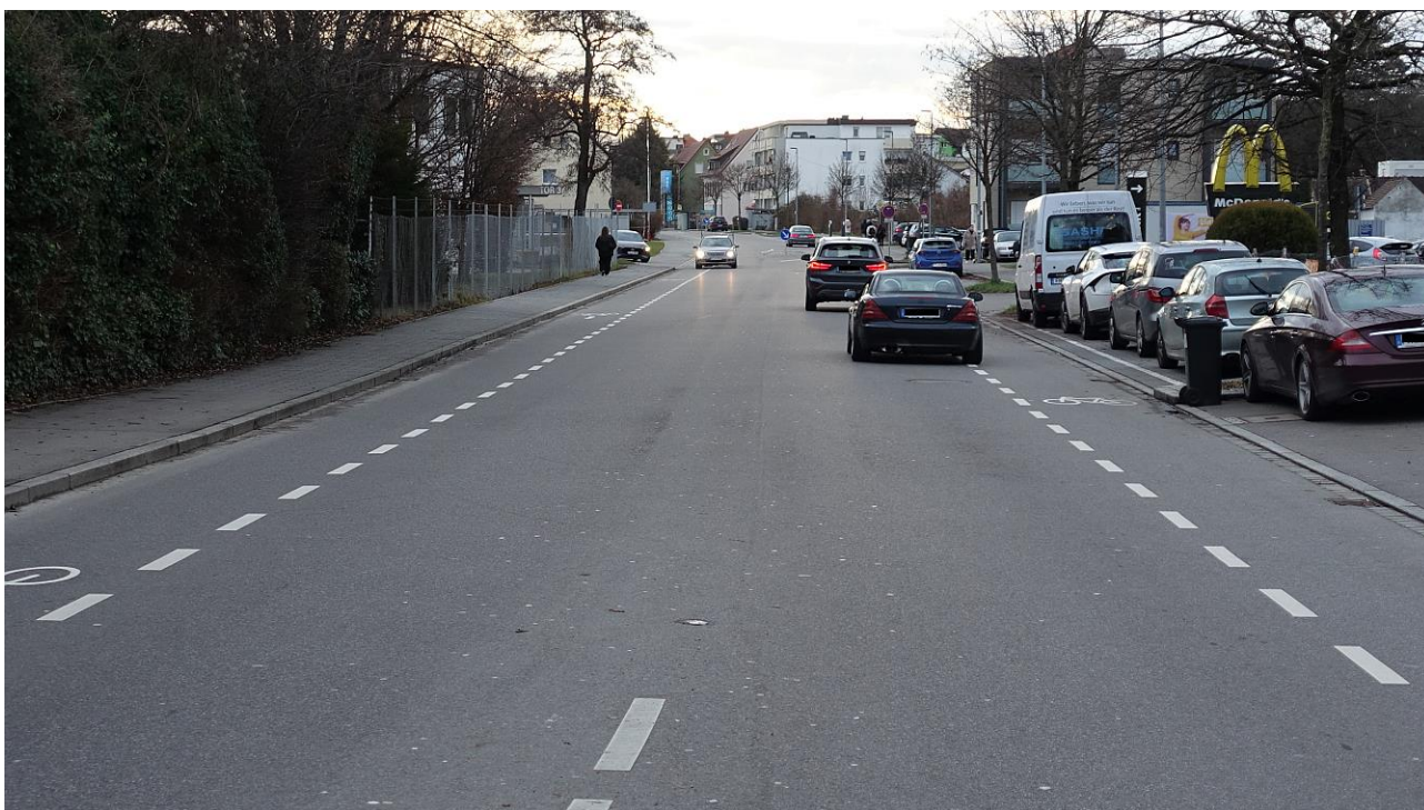
Östliche Löwentaler Straße, Blick Richtung Westen
