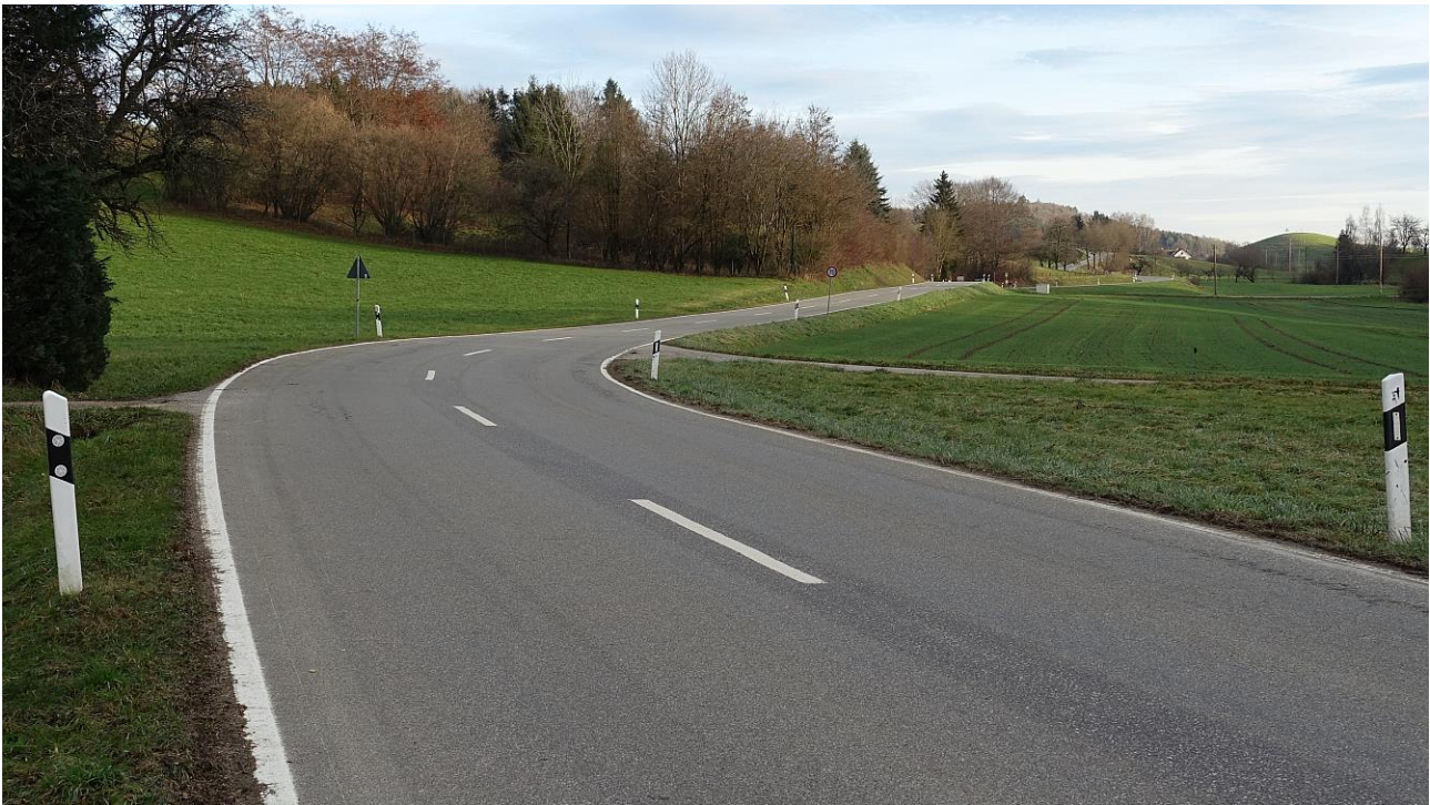
K 7786 zwischen Nesselwangen und Bonndorf, Höhe Enschbach, Blick Richtung Osten
