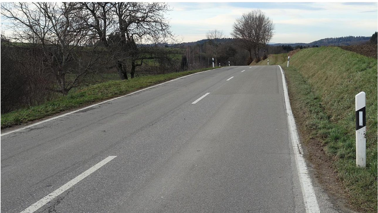
K 7786 westlicher Ortsausgang Nesselwangen, Blick Richtung Westen
