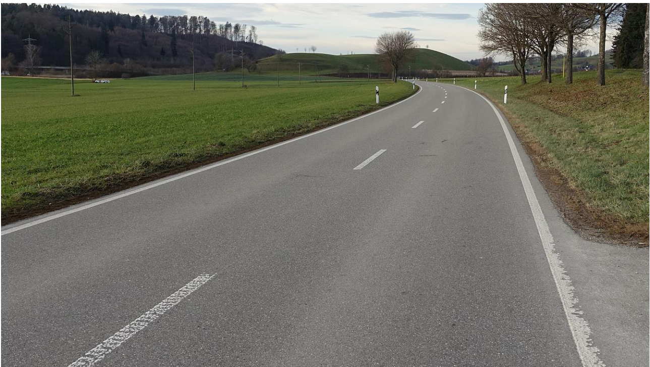
K 7786 östlich von Nesselwangen Höhe Ösch/Hohenlinden, Blick Richtung Westen
