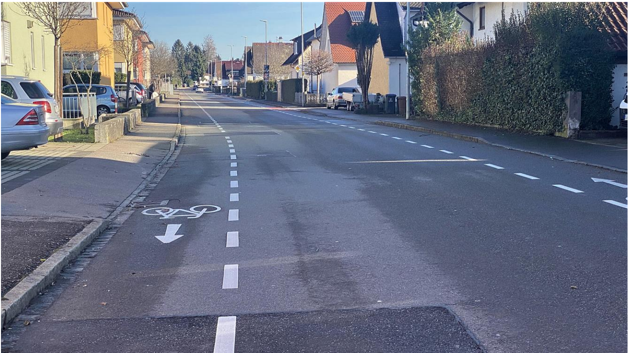
Westliche Bernhardstraße, Blick Richtung Osten
