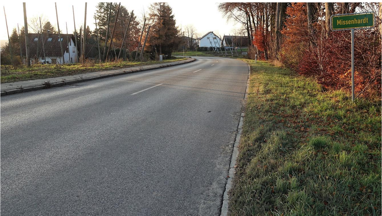
Wangener Straße außerorts, Missenhardt, Blick stadteinwärts Richtung Westen
