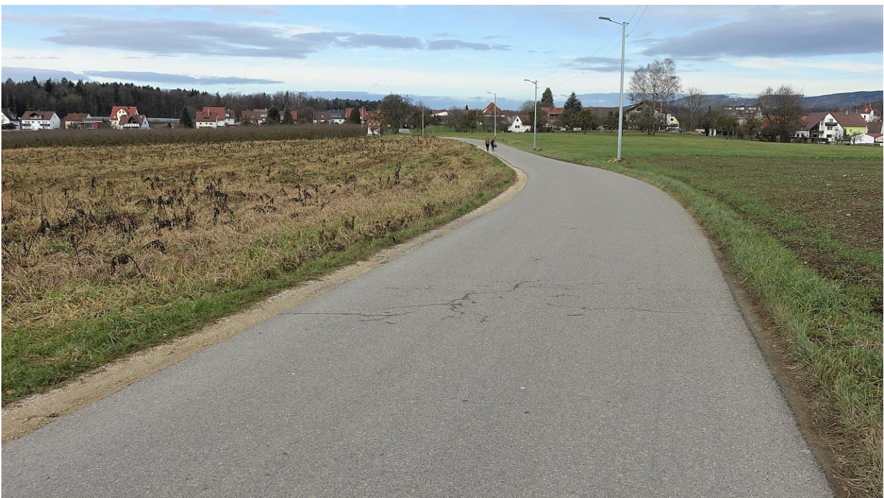
Nördliche Windhager Straße, Blick Richtung Norden
