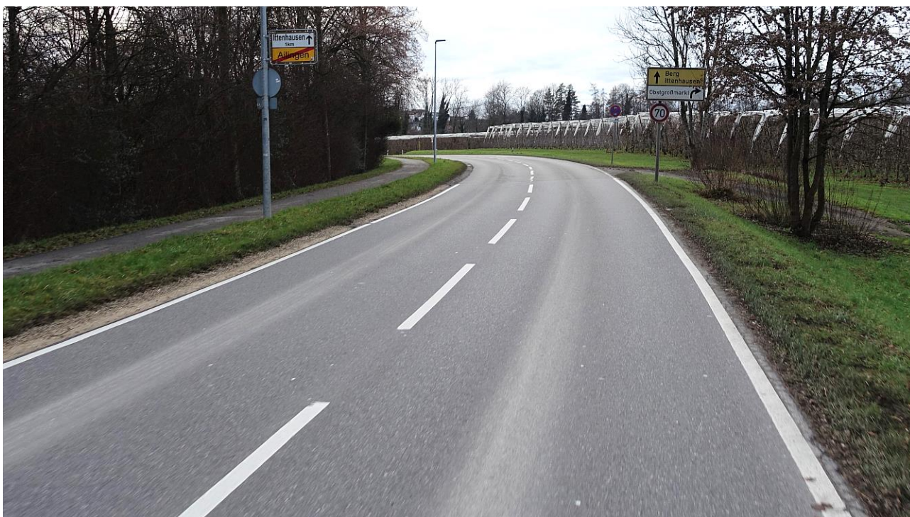
Ittenhauser Straße Ortschaftsausgang, Blick Richtung Westen
