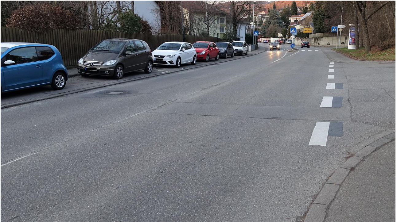
Frohsinnstraße Höhe Obere St.-Leonhard-Straße, Blick Richtung Norden
