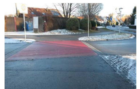
Beispiel einer Furt, die mit der nach hinten versetzten Streckenführung eine Aufstellfläche für den wartenden Kfz-Verkehr bietet. Die Aufmerksamkeit der Kfz-Fahrer beim Ab-/Einbiegen wird entzerrt.
