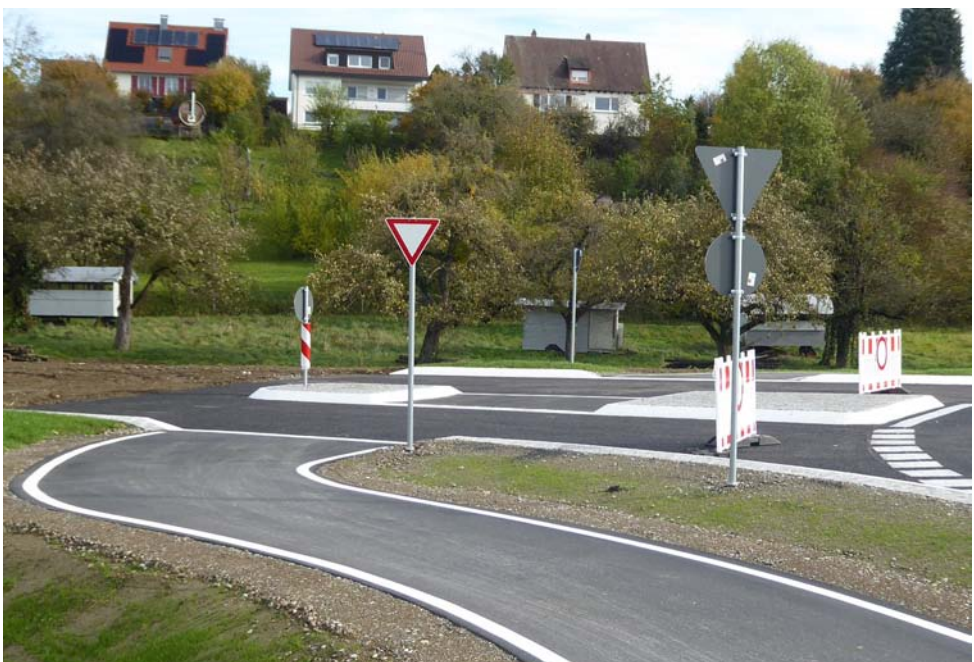
An der Querung des neuen Rad- und Fußwegs über die Zufahrt zum Neubaugebiet „Klosterörschle“ muss der Radverkehr „Vorfahrt gewähren“, wie es an Kreisverkehren außerorts üblich ist. Nach dem Bau des neuen Wohngebiets kann die Straße zum Innerorts-Bereich werden, dann müsste hier Vorrang für Rad- und Fußverkehr gelten. Und es wäre auch ein zweiter Radweg auf der anderen Seite der Kreisstraße vorzusehen. Solange hier kein Kfz-Verkehr fährt, sollten die Vorfahrt-Gewähren-Schilder abgeklebt werden! fs
