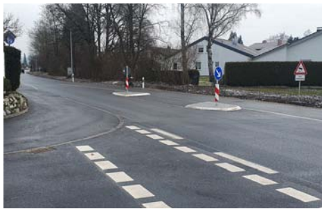
Die neue Querungshilfe am Ortseingang von Gaisbeuren funktioniert, Pfeile bei der Ein- und Ausleitung auf den Rad-/Gehweg wären hilfreich.
