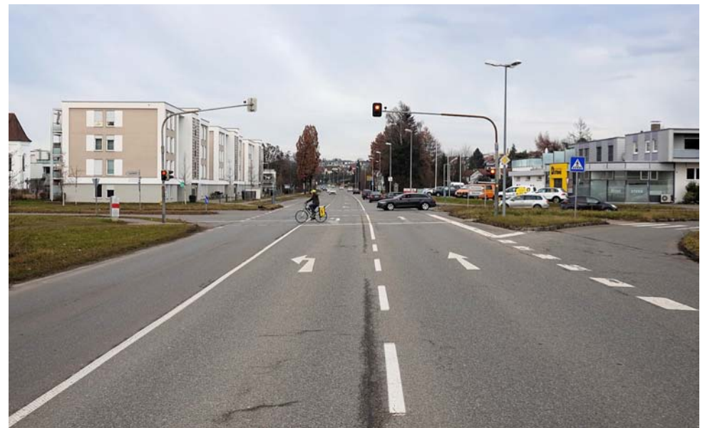
Die Lindauer Straße im Süden von Tettang mit der Kreuzung zum Oberhof und Schäferhof wurde in Zeiten der „autogerechten Verkehrsplanung“ gebaut. Mittlerweile ist der Knoten eine Unfallhäufungsstelle, weshalb er 2026 zu einem Kreisverkehr umgebaut wird. bg
