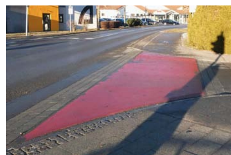
Eine Querungsfurt, die nah an der Fahrbahn verläuft und daher von wartenden Kfz wegen der Sichtverhältnisse oft blockiert wird. Rad-Piktogramme, Blockmarkierungen und Pfeile fehlen an dieser Furt.
