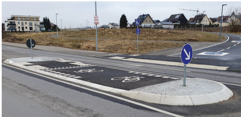
Die Querunginsel in der Wagershauser Straße wurde mustergültig barrierefrei mit differenzierten Bordhöhen gebaut: Neben der großen Aufstellfläche für Radfahrer besteht ein Fußgängerbereich mit einer kantenlosen Auffahrt für Rollstühle und ein Abschnitt mit einer taktilen Kante für Blinde. (bg)
