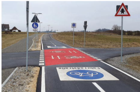
Bei den Querungen von Straßen wurde der Veloring bevorzugt und vorbildlich markiert. (bg)
