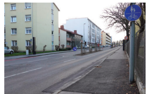
Durch die Absenkung des Bordsteins wie hier gegenüber der Einmündung der Brunnenstraße kann jetzt auch ins Wohnquartier geradelt werden (und umgekehrt). (bg)
