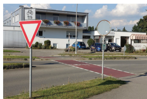
An der Einmündung der Oberhofer Straße in die Lindauer Straße quert heute ein gegenläufiger Radweg. Diese Querung wird es auch beim Kreisverkehr geben. (bg)
