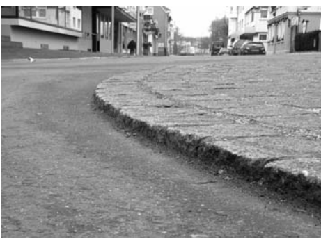
Dank des Absatzes am Innenring bleiben die Autos auf der äußeren Spur. Wichtig, damit der Verkehr im Kreisler langsamer und sicherer wird.
