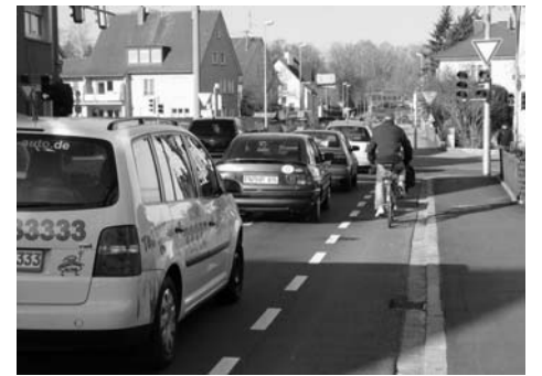
Heute: Der neue Schutzstreifen führt Radler sicher an den Autos vorbei zur Ampel.
