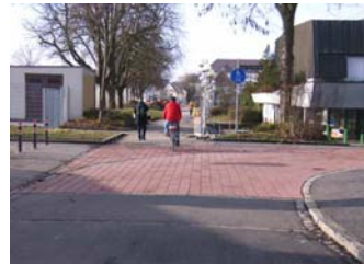
Nachher: Der Durchlass wurde verbreitert und im Zuge der Scheffelstraße geradlinig ausgebaut.
