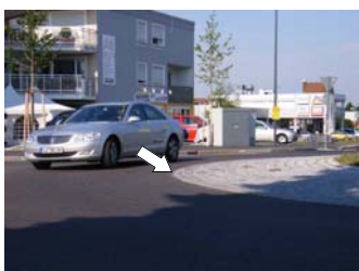
Beim Kreisverkehr an der Rheinstraße wurde der gepflasterte Innenring vorschriftsgemäß mit Absatz (Pfeil) gebaut. Dadurch fließt der Verkehr langsamer.
