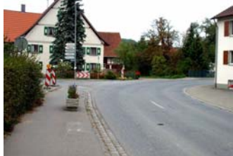
L204, Einmündung Moorhofweg: Vorher standen Blumenkübel auf dem Radweg, um ihn von Autofahrern freizuhalten.
