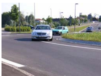
Beim Komm-Kreisverkehr dagegen wurde der obligatorische gepflasterte Innenring erst gar nicht gebaut. Die Folge ist, dass viele den Kreisverkehr zu schnell durchfahren.
