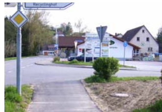
Nachher: Die Ausleitung des Radweges wurde begradigt und am gegenüberliegenden Radweg eine Absenkung eingebaut.
