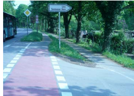
Vorher: An der westlichen Einfahrt des Seemooser Weges begannen die schmalen Streifen für Radler und Fußgänger.
