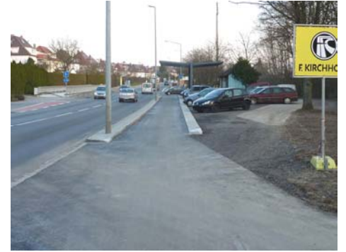
Nachher: Die geradlinige Führung vor der Tankstelle verbessert auch die Situation an der Einmündung des Reiherwegs.
