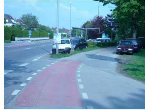
Vorher: An der ehemaligen Tankstelle beim Reiherweg verlief der Radweg unübersichtlich und war oft zugeparkt.
