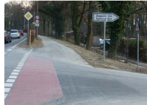
Nachher: Der breite Fuß-/ und Rad und die neu gepflanzte Hecke für den Blend- und Spritzschutz sind ein Meilenstein.
