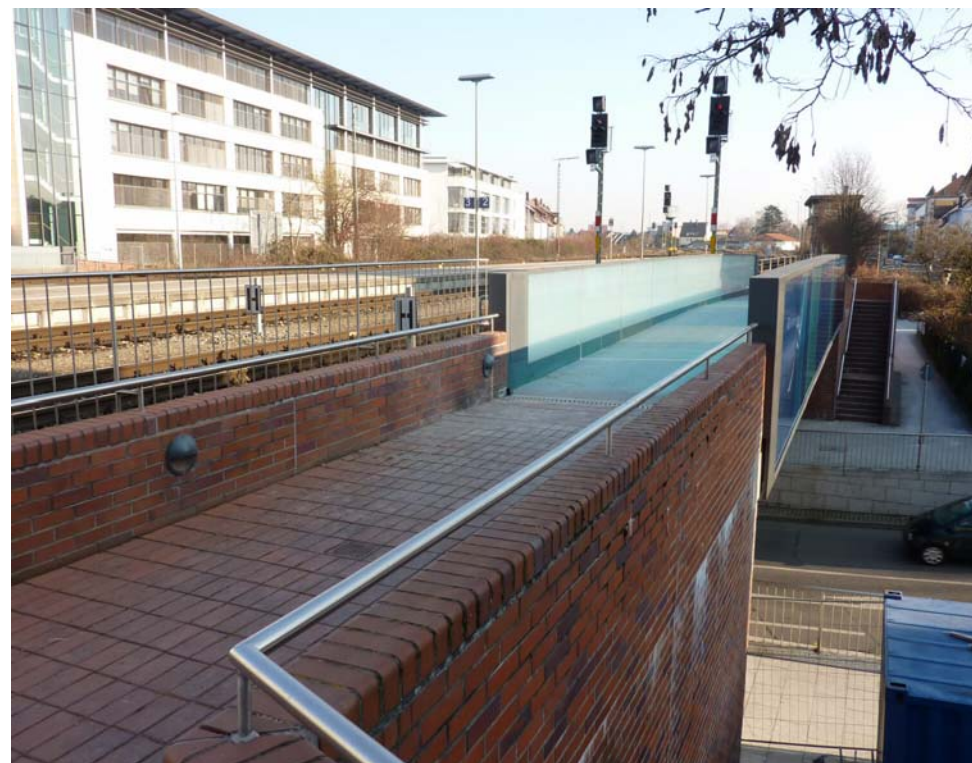
Die beiden Brücken über die Riedleparkstraße (hier die südliche Brücke) sind wichtige Bausteine im Routennetz für Fußgänger und Radfahrer.
