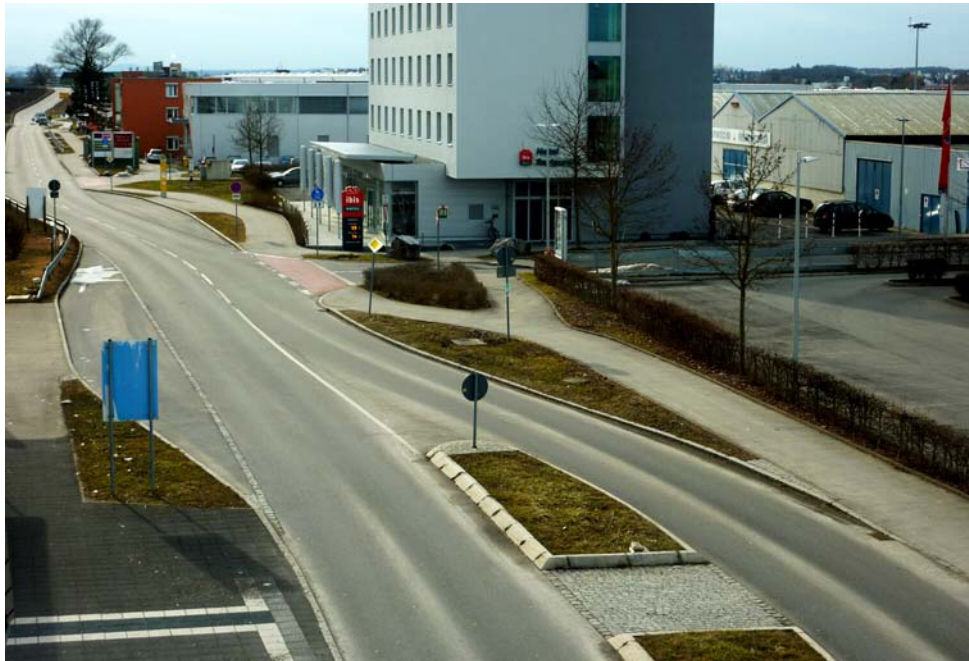
Der Radweg entlang des Flughafens ist für Radfahrer ein lästiger Slalom mit gefährlichen Fallen an den zahlreichen Einmündungen. Der Blick von der Bahnüberführung offenbart, wie fahrradunfreundlich der Radweg angelegt ist.
