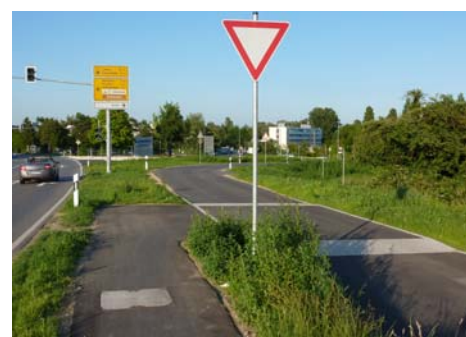
Auf der Südseite der B31 endet der Radweg aus Westen und wird auf den Gemeindeverbindungsweg eingeleitet. Bei der Einleitung in die Fahrbahn bremst ein Plaqueau den Kfz-Verkehr ab.
