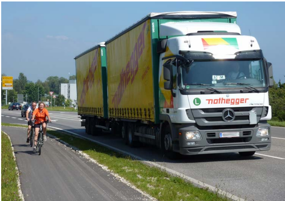
Das Bild zeigt den 2,0 m schmalen Radweg auf der Nordseite des Dornierknotens. Die Behörden legten die Route des Bodensee-Radweges wieder direkt an die stark befahrene Bundesstraße, anstatt die vorhandenen straßenfernen Wege zu nutzen! Aus Sicht des ADFC ist dies eine unverantwortliche Entscheidung, die den Bodensee-Radweg zwischen Friedrichshafen und Immenstaad weiterhin zur Horrorstrecke macht.
