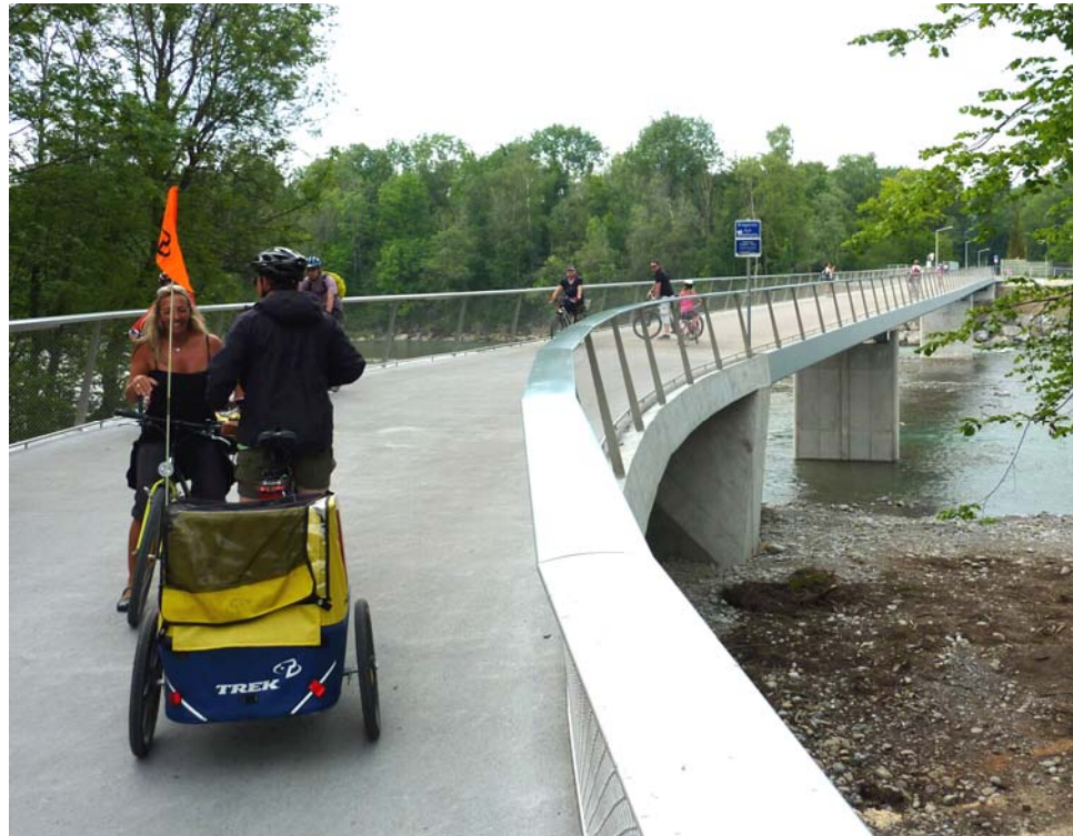
Auf der neuen Fußgänger- und Radlerbrücke über die Bregenzer Ach in Vorarlberg ist ausreichend Platz für alle. Hier sind Radler willkommen!
