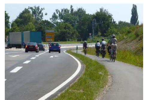
Auf dem 2,0 m breiten gemeinsamen Fuß- und Radweg an der L207 mit einem 1,25 m breiten Grünstreifen sausen Radler zur B31 hinunter. Die vorgeschriebenen Mindestmaße werden deutlich unterschritten!
