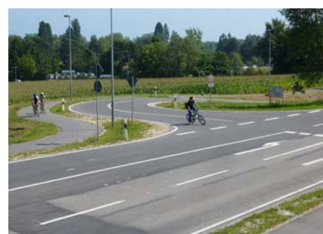
Die Einmündung der Straße von der Dornierunterführung in die L207 ist ein weiterer Beweis für die Fehlplanung. Wer als Radler diese Straße benutzt, gelangt nur über einen Grünstreifen auf den Radweg.
