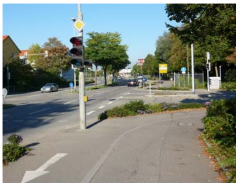
Vorher: Der Radweg an der Ehlersstraße verlief bei der Zufahrt zur ZF-Hauptpforte kurvig und unübersichtlich, der (zulässige) Gegenverkehr war schwer zu erkennen.
