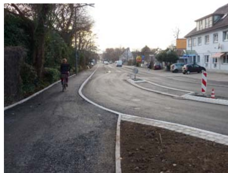
Nachher: Auf einem neuen Verkehrsteiler wurde eine lange Wartefläche gebaut, auf der sich Radler aufstellen können, dadurch sollen Geisterradler verhindert werden.
