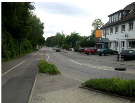
Vorher: Der Radweg an der Ehlersstraße mündet in die Löwentaler Straße. Hier muss die Querung auf den nördlichen Radweg der Löwentalerstraße erfolgen.
