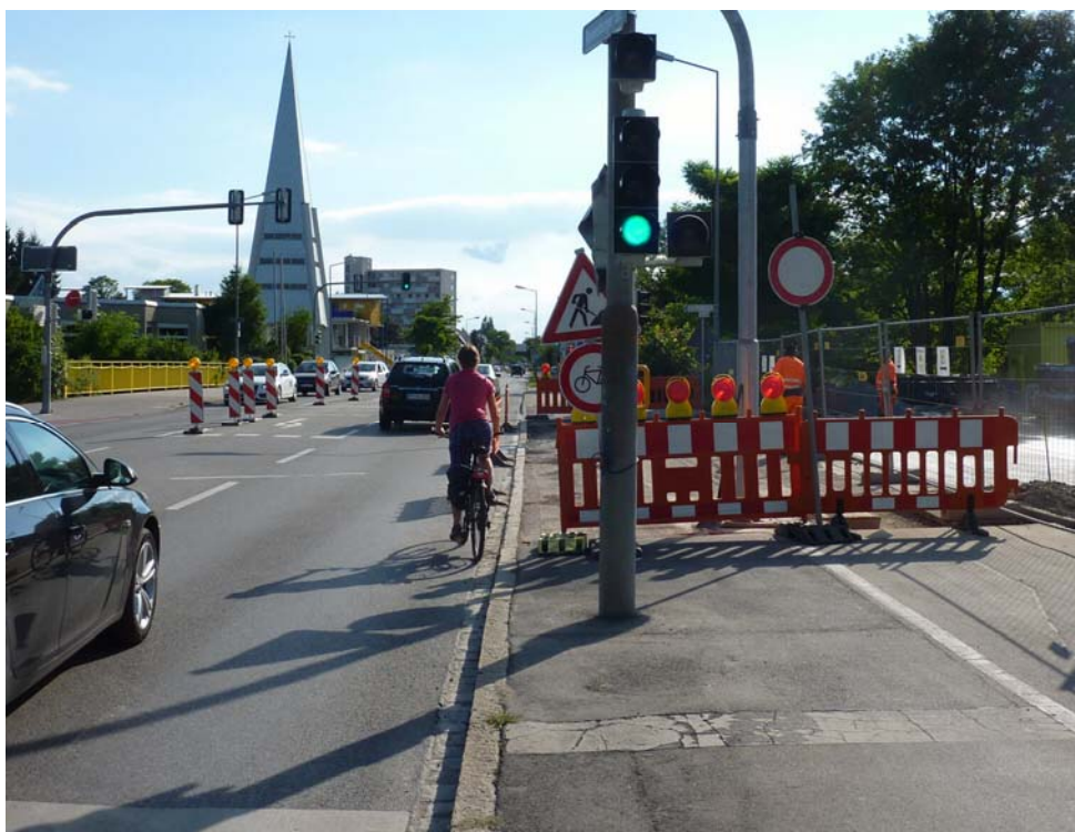
Das neue Häfler Radverkehrskonzept soll auch Verbesserungen für Radfahrer an Baustellen bringen. Eine bloße Absperrung mit einer ungesicherten Ausleitung auf eine Hauptstraße, wie hier 2012 an der Ravensburger Straße, sollte damit der Vergangenheit angehören.
