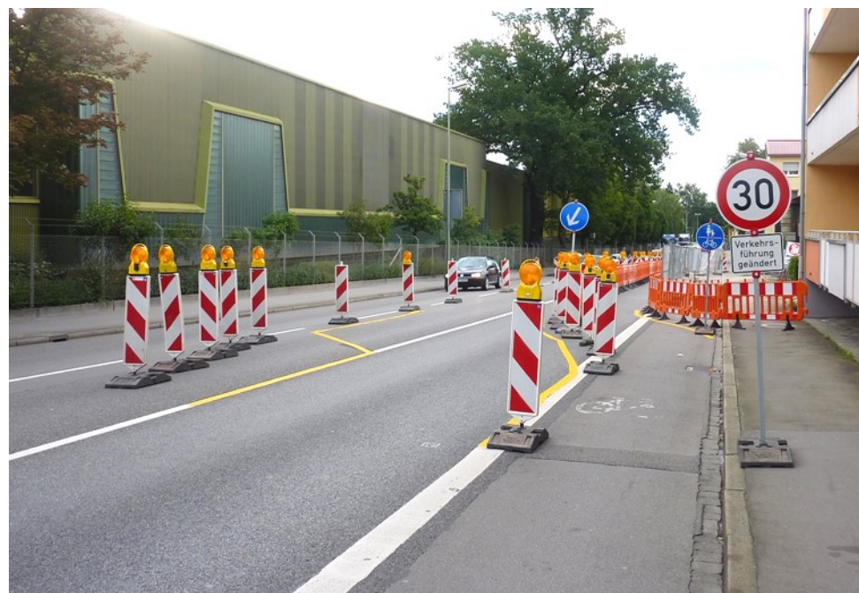
Auf der Maybachstraße wurde einer der drei Fahrstreifen aufgehoben, um den Radfahrstreifen weiterzuführen. Der ADFC hofft, dass dieses Beispiel Schule macht.
