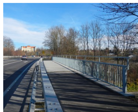
Nachher: Der Radweg wurde – auf Vorschlag des ADFC – im Zuge der Brückenrenovierung verbreitert.
