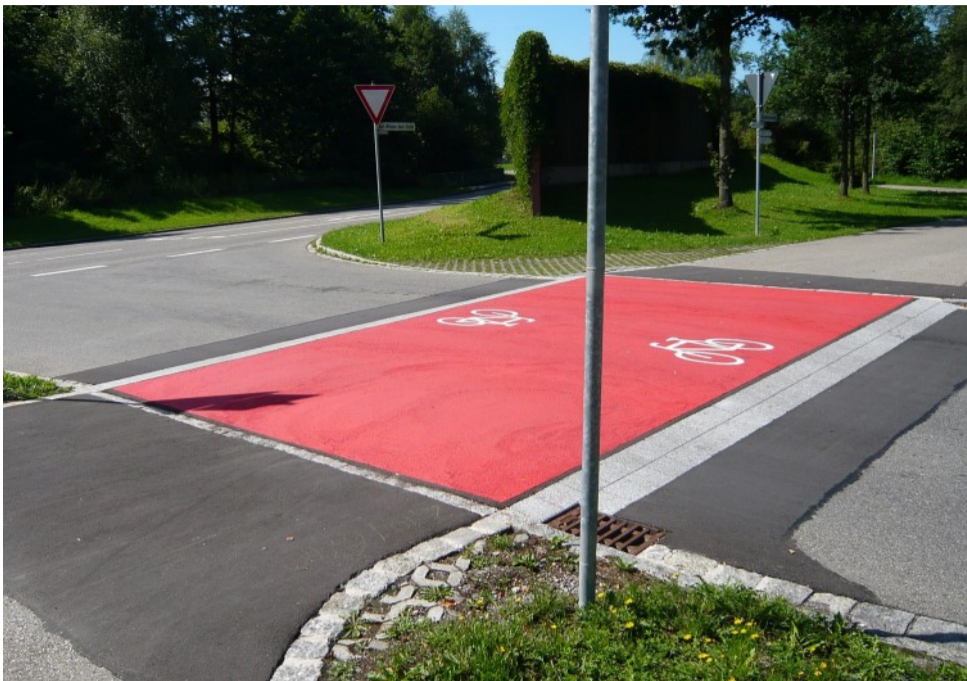
In Isny können die Schüler den Känerweg nun auf einer roten, angehobenen Furt bevorrechtigt queren.
