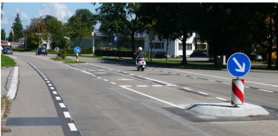
Geteilte Querungshilfe an der Maierhöfener Straße in Isny: Hier können Radler im Schutz der Inselköpfe den Verkehr der anderen Fahrtrichtung abwarten.
