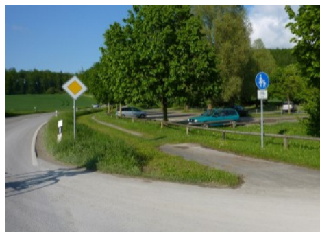
Der Radweg an der K 7765 am Affenberg in Mendlishausen wird ausgebaut. Der ADFC hat sich auch für Querungsiseln mit mindestens 3,0 m Breite eingesetzt.
