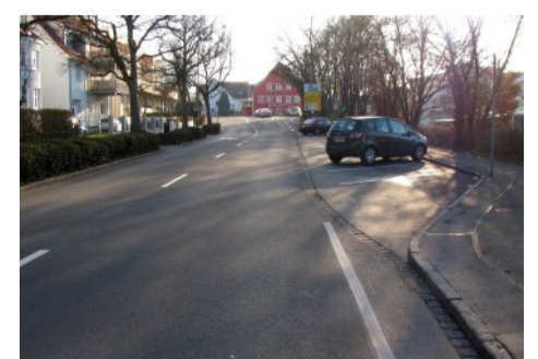
In der sanierten Bahnhofstraße in Weingarten sind Radverkehrsmaßnahmen fehlgezeigt. Das Radkonzept ist offenbar in Frührente gegangen.
