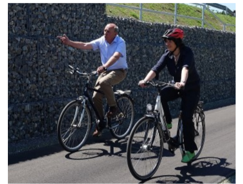
Jürgen Waldherr erläutert Staatssekretärin Gisela Splett (re.) die mächtige Stützwand des Radweges.
