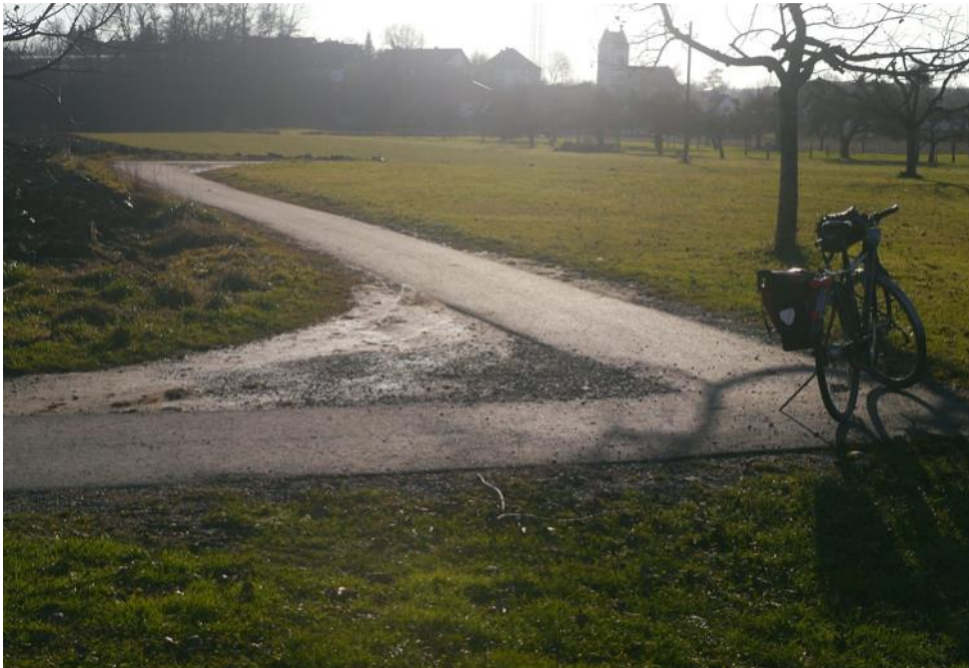
Der Apfelweg westlich von Leimbach wurde asphaltiert und dabei mit rechten Winkeln ausgebaut statt mit Kurven. Radfahrer haben die Kurven mittlerweile selbst angelegt. Der Zustand des Weges ist für eine Route des RadNETZ, das hier verläuft, nicht akzeptabel.
