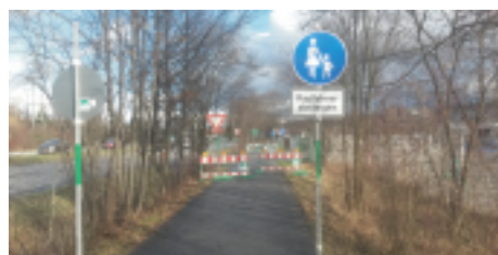
No-Go: „Radfahrer absteigen“ an der Baustelle, auch an der Ulmer Straße Foto: Stefan Valentin
