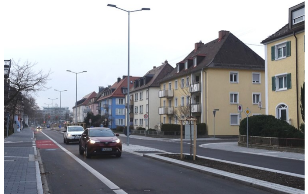
2018 wurde die Keplerstraße umgestaltet und das 16 Jahre bestehende Provisorium abgelöst. Der Straßenquerschnitt wurde völlig neu aufgeteilt. Gut sind die breiten Radfahrstreifen, die bereits im Provisorium vorhanden waren. Leider wurde die Mittelinsel zu schmal gebaut. Schlecht für querende Radfahrer und die ärmlichen Bäume im Grünstreifen. (bg)
