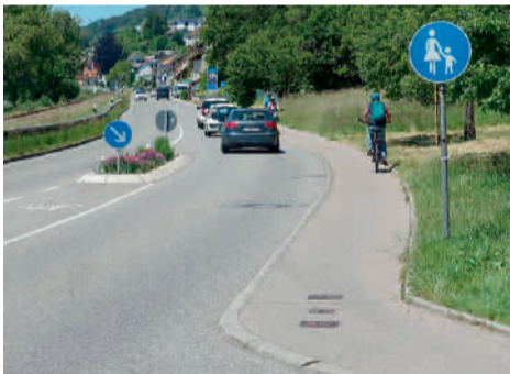
Am östlichen Ortsende von Sipplingen fehlt eine Einleitung des Bodensee-Radweg auf die Fahrbahn der alten B 31.
