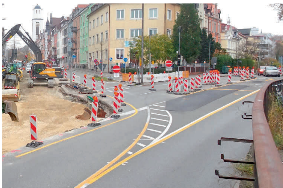
Bei der Neugestaltung des Sternenplatzes hat leider die Baustellenführung für Kraftfahrzeuge Vorrang. (wf)
