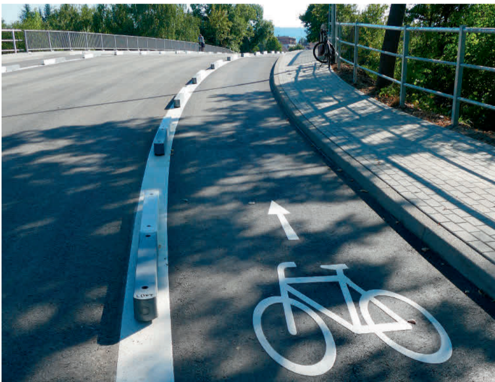
Auf der Brücke der Konstanzer Straße in Radolfzell wurden auf dem neuen Radfahrstreifen zunächst Segmentblöcke angebracht, nach einigen Kollisionen und Leserbriefen aber wieder entfernt. (hb)
