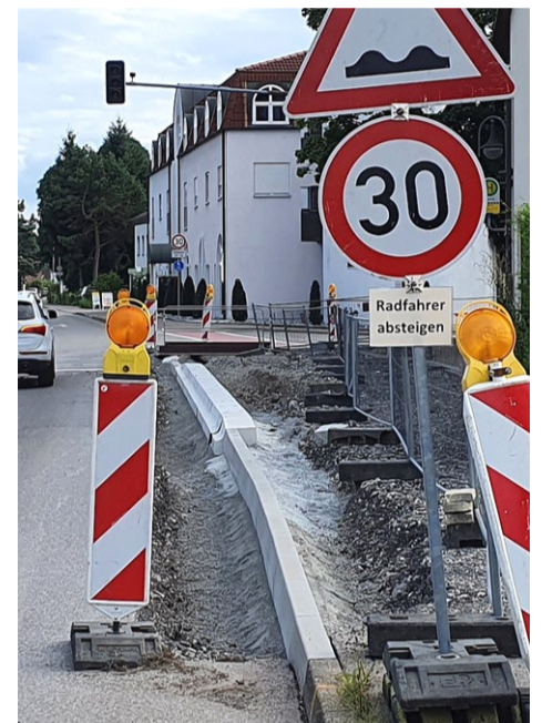
Der Baustellenleitfaden der agfk-bw erklärt genau, wie man den Radverkehr an Baustellen ohne Absteigen führt. (bg)
