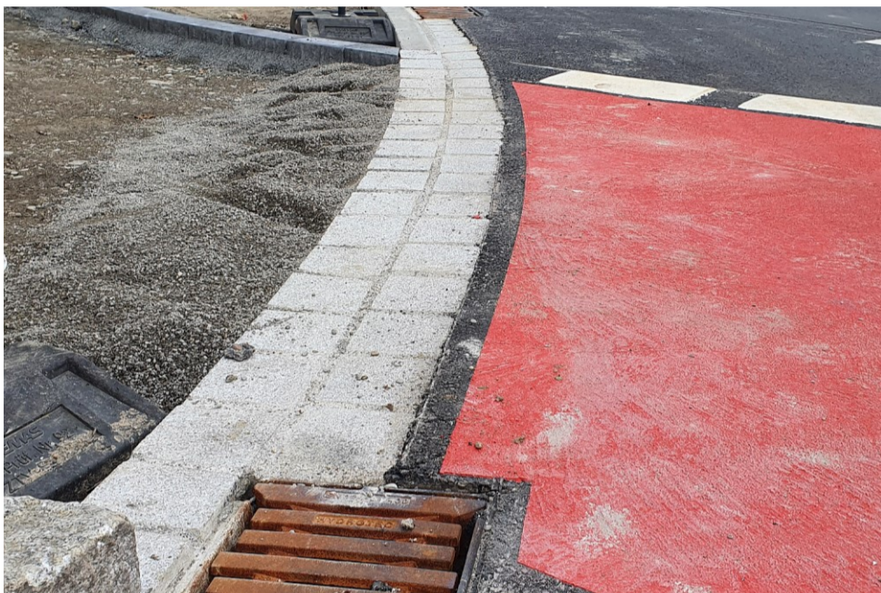
Ein perfekter Übergang vom Radweg auf die Fahrbahn setzt scharfkantige Steine und gute Asphaltarbeit voraus. Dies ist an der Einmündung der May-Eyth-Straße (Bild) gelungen. Wichtig: Für die Wasserführung ist kein Höhenanschlag erforderlich. (bg)
