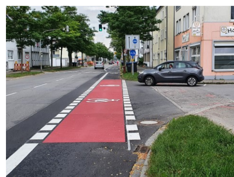
Die Einmündungen sind nun sicherer, Autos stehen nicht mehr auf der Radfurt. (bg)
