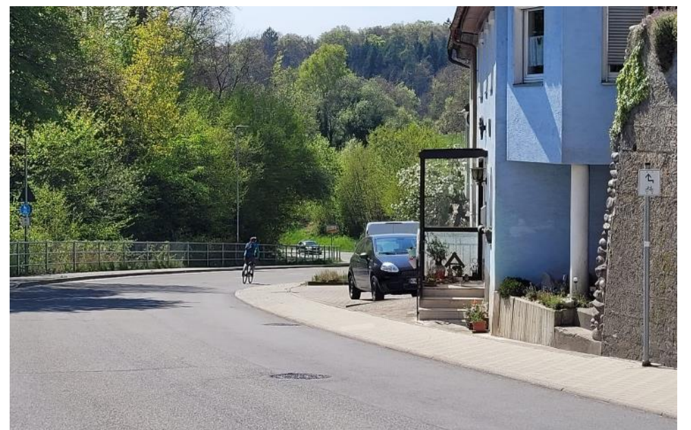
Die Bodanrückstraße am Ortsausgang Liggeringen ist beschierungs- und markierungsmäßig eine Wüste! (khs)
