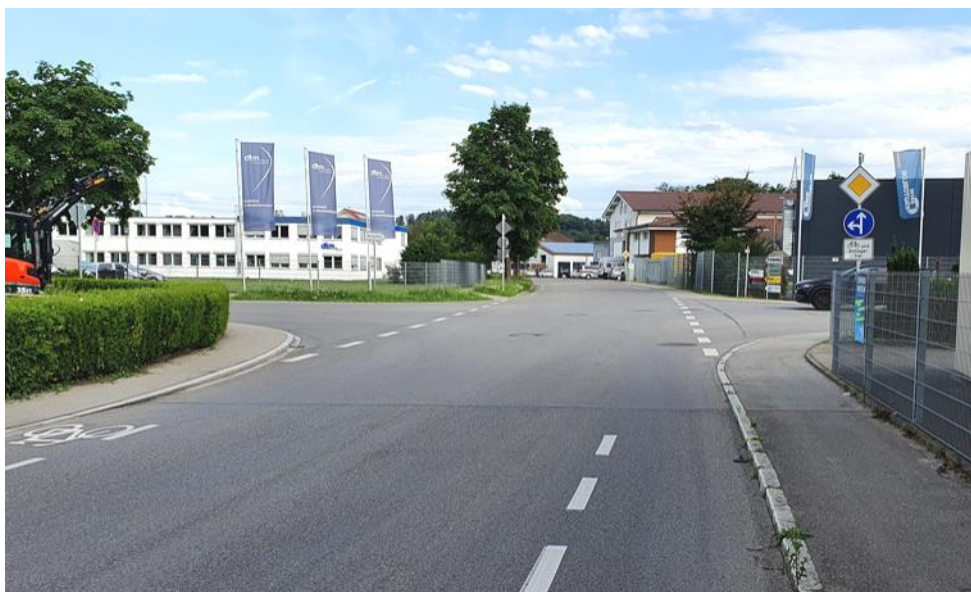
Die Schutzstreifen auf der Daimlerstraße enden plötzlich an der Kreuzung der Wiesentalstraße, obwohl sie bis zum Ortsende an der Dieselstraße fortgesetzt werden könnten. (bg)
