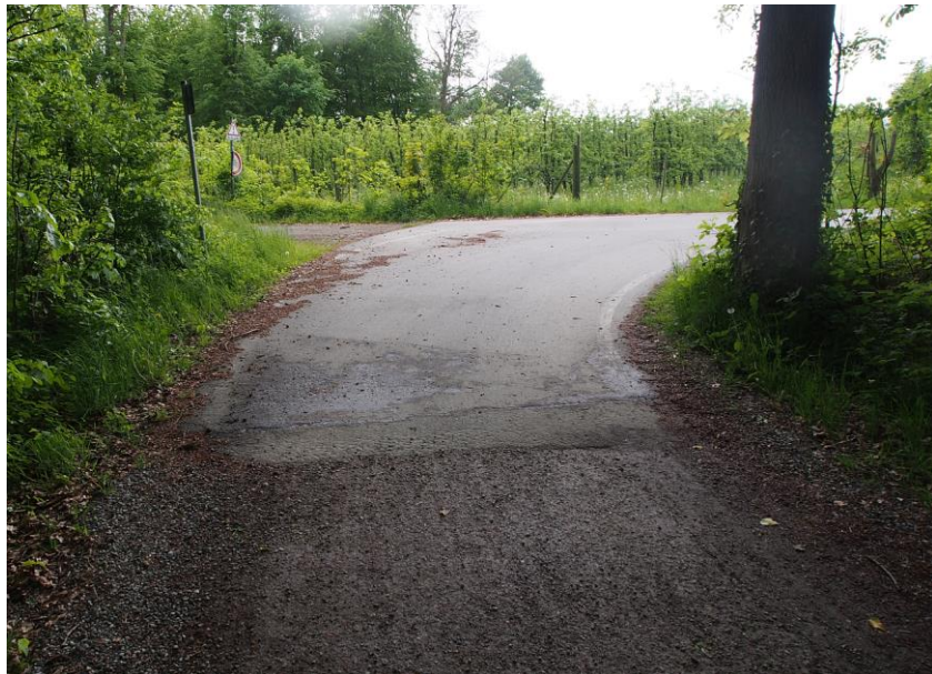
Bild 23: Immenstaad Kirchberg, Belagswechsel in der Kurve
