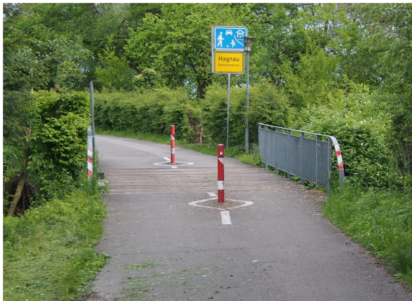
Bild 19: Stetten / Hagnau, Brücke an der Ortsgrenze
