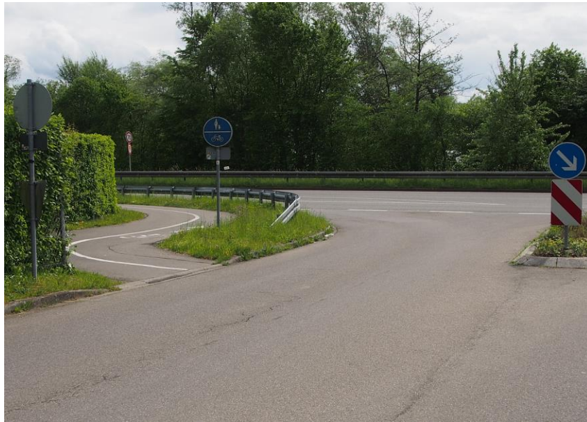
Bild 5: Sipplingen, ungenügend abgesenkter Bordstein
