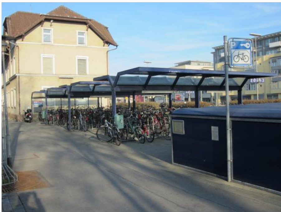
Abbildung 8-2: Fahrradabstellanlagen am Stadtbahnhof
