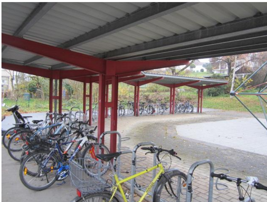
Abbildung 8-1: Vorderradhalter mit Rahmenfixierung vom Typ Beta in einer überdachten Anlage an der Grund- und Realschule in Ailingen
