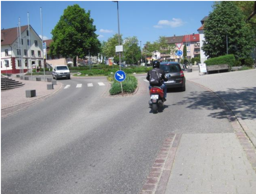
Abbildung 3-7: Gestaltung der Kreisverkehrseinfahrt
