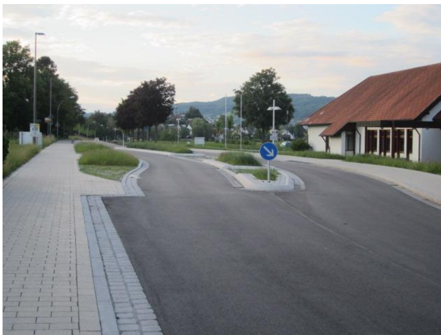
Abbildung 7-6: Neue Querungshilfe in der nördlichen Ortseinfahrt von Kluffern
