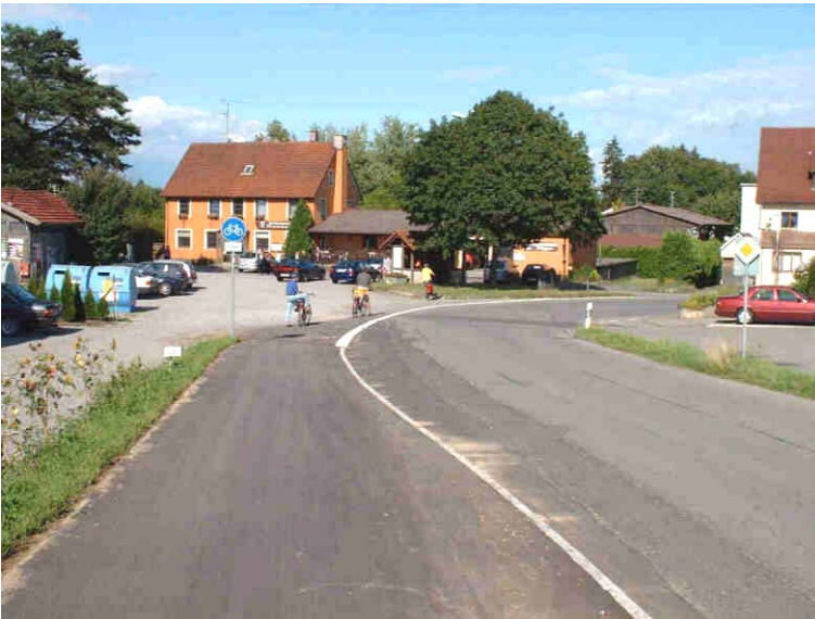
Bild 10 Rampe östlich der Bahnlinie (Blick bergab)
