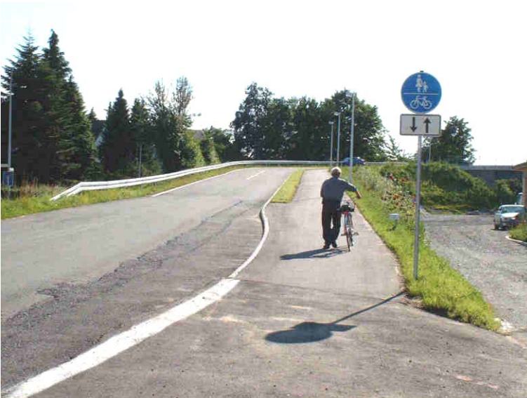
Bild 11 Rampe östlich Bahnlinie (Blick bergauf)
