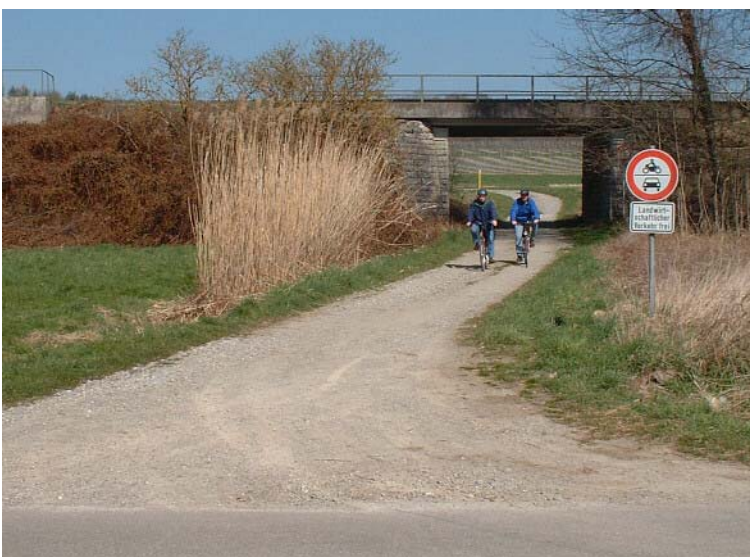
Bild 10 Bahnunterführung Mauracher Straße zwischen Hof Möking und Pilgerhof
