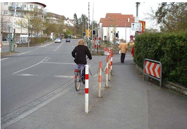
Bild 15 Bahnübergang Ost, Blick in Richtung Nord-Ost
