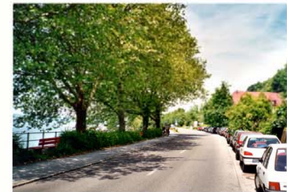
Westlich von Meersburg, Blick Richtung West
