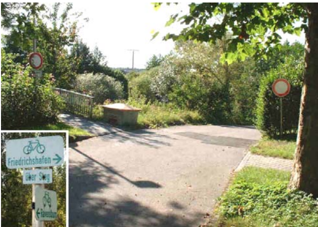
Bild 12a Brücke über Schussen
