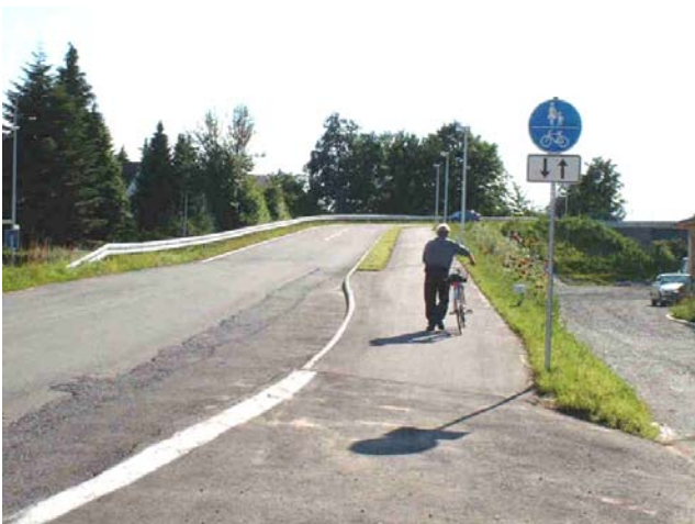
Bild 11a Rampe östlich Bahnlinie (Blick bergauf)
