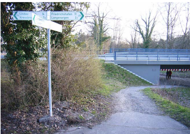
Bild 34 Östliche Argenseite, Zufahrt Richtung Gohren Die Durchfahrt unter der neuen Argenbrücke ist unbefestigt und sehr steil.
