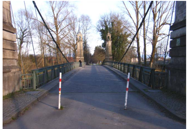
Bild 33 ☺ Der mittlere Pfosten wurde entfernt.
