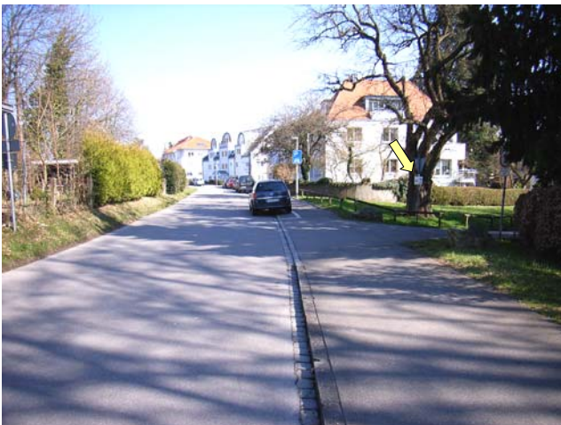
Bild 1 Schmidstraße, Einmündung Grundstraße Der Zwischenwegweiser Richtung Grundstraße liegt nicht in der Sichtachse des Radverkehrs.
