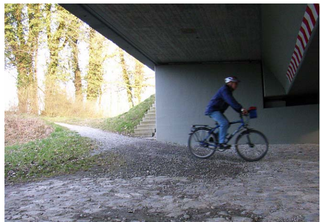
Bild 35 Östliche Argenseite, Zufahrt Richtung Gohren Die Durchfahrtshöhe der neuen Argenbrücke ist sehr niedrig (< 1,8 m).
