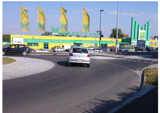
Bild 30: Kreisverkehrsfahrbahn mit gepflastertem Innenring und Höhenabsatz
