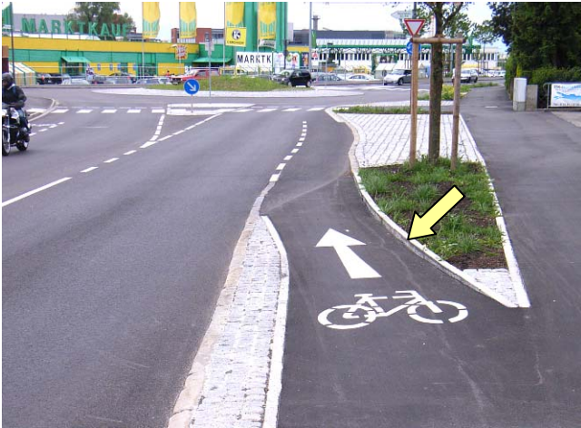
Bild 27: Nördliche Einfahrt, Fahrtrichtung stadteinwärts (Bordsteinkante, Pfeil)
