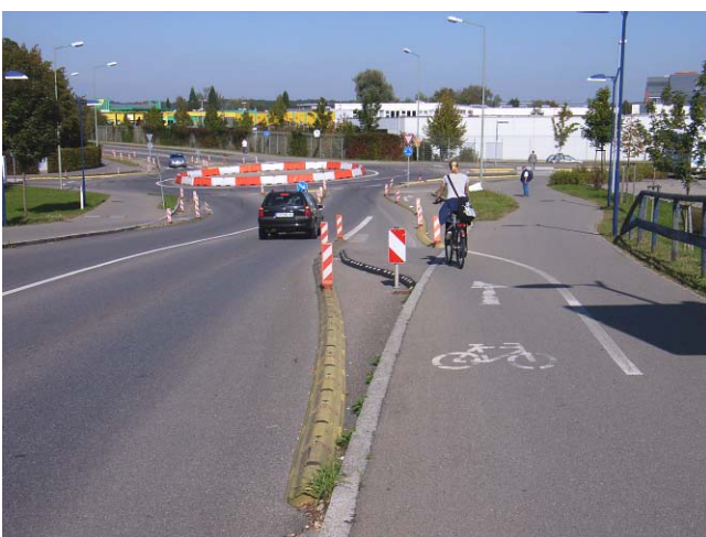
Bild 4: Einleitung des Radweges am provisorischen Komm-Kreisverkehr, Fahrtrichtung Ailingen
