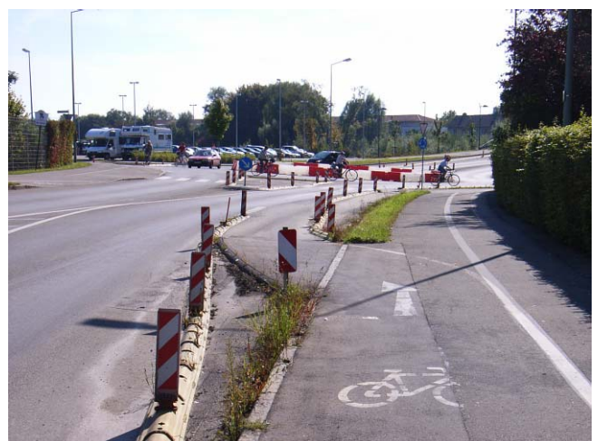
Bild 5: Einleitung des Radweges am provisorischen Komm-Kreisverkehr, Fahrtrichtung Innenstadt
