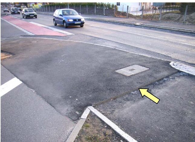
Bild 13: An der Zufahrt zum Marktkauf (neben ZF-Einfahrt) wurde Feinbelag aufgebracht, beim Radweg endet er
