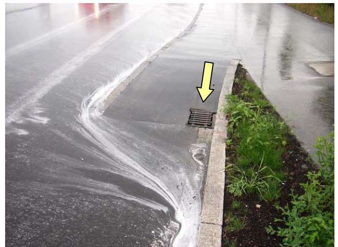
Bild 20: Entwässerung und Wasserführung bei der Ausfahrt stadteinwärts (Rotachbrücke)
