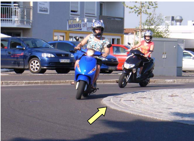
Bild 29: Kreisverkehrsfahrbahn mit gepflastertem Innenring und Höhenabsatz (Pfeil)
