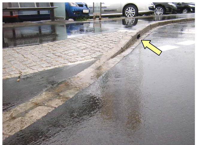
Bild 34: Bushaltestelle Löwental, Bordsteinübergang bei Regen (Ablaufschacht ⇨ Pfeil)
