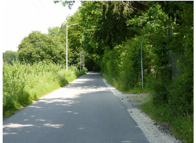
Bild 12: Westliche Zufahrt von der Windhager Straße, Blick Richtung Norden
