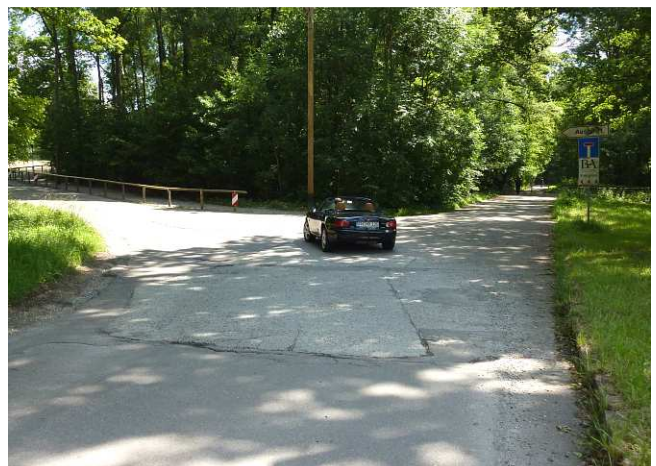
Bild 8: Östliche Zufahrt, links Richtung Sparbruck, geradeaus Richtung Hochstraße, Blick Richtung Osten
