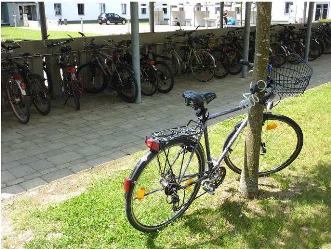
Bild 23: Fahrradabstellanlage an der DHBW; das Anschließen des Rahmens ist mit einem Korb nicht möglich
