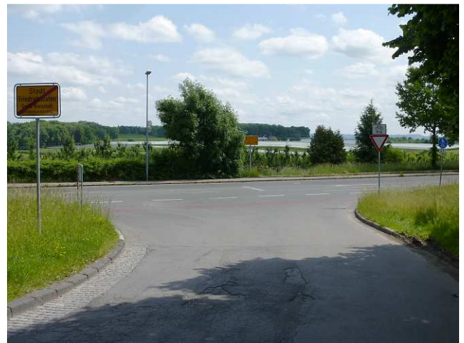
Bild 5: Östliche Zufahrt in Sparbruck, Blick vom Fallenbrunnen auf die Hochstraße
