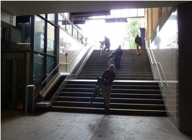
Bild 8: Der Zugang zur Bahnstufunterführung und den Gleisen 2 bis 6 ist von Süden nur über eine Treppe oder einen Aufzug mit zu geringer Transportkapazität möglich.
