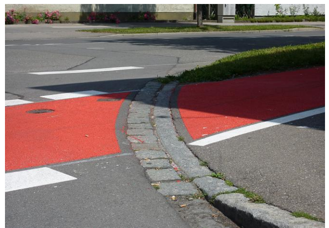
Bild 13: Unzureichend abgesenkter Bordstein an der Einmündung der Gebhardstraße
