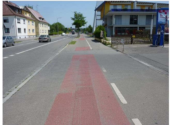
Bild 30: Paulinenstraße östlich des Bahnübergangs: Verschlissene Markierungen
