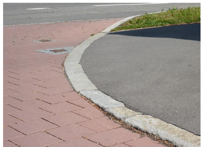
Bild 17: Ausreichend abgesenkter Bordstein an der Einmündung der Georgstraße
