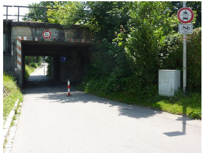
Bild 59: Bahnunterführung der südlichen Aistegstraße, Nordseite
