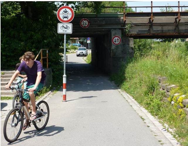
Bild 58: Bahnunterführung der südlichen Aistegstraße, Südseite
