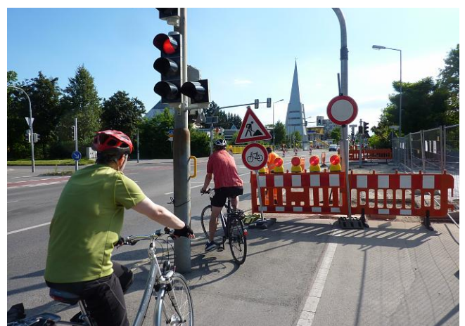
Bild 46a: Ravensburger Straße, Foto 9. Juli 2012: Diese private Baustelle (Lidl) sieht für den Rad- und Fußverkehr keine alternative Führung vor, weitere Bilder ⇨
