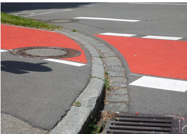
Bild 12: Unzureichend abgesenkter Bordstein an der Einmündung der Gebhardstraße
