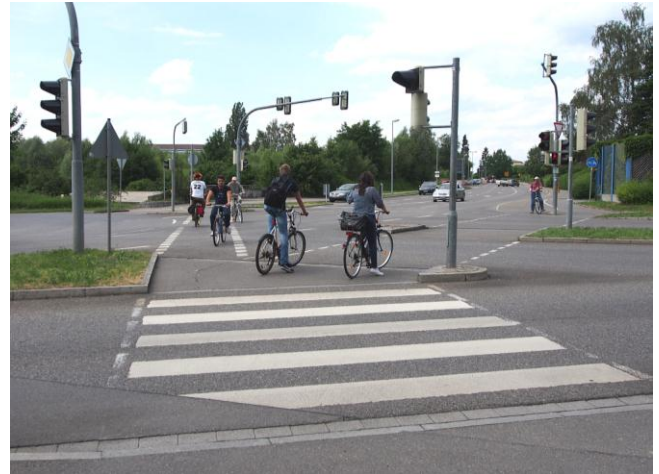
Bild 13: Die Querung des Bypasses von der Colsmannstraße zur Riedleöschstraße erfolgt über einen Fußgängerüberweg. Die anschließende dreieckförmige Wartefläche ist zu klein.
