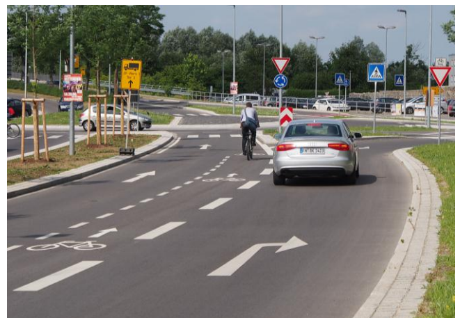
Bild 23: Die als Schutzstreifen markierte Einleitung aus der Ehlersstraße in den Kreisverkehr der Flugplatzstraße und Mühlöschstraße wird von Radfahrern angenommen.
