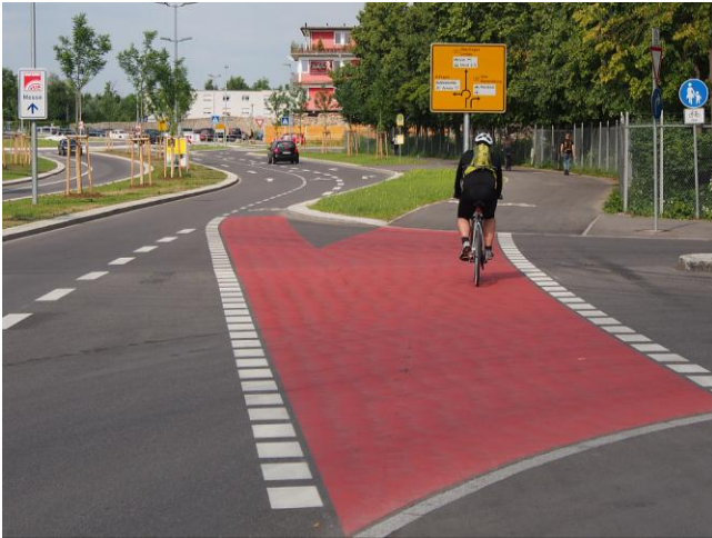
Bild 30: An der Einmündung der ZF-Werkszufahrt weist ein „roter Teppich“ auf den kreuzenden Radweg hin und zeigt die möglichen Fahrbeziehungen an.
