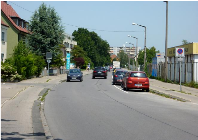
Bild 34: Die Löwentaler Straße vor dem Umbau 2012, Blick Richtung Osten.
