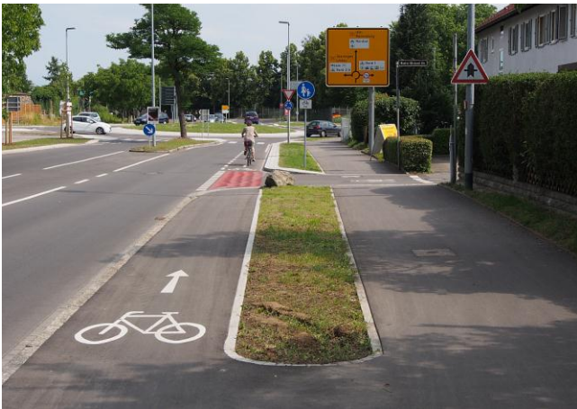
Bild 20: Bei der Ausleitung vom Radweg an der Mühlöschstraße zum Kreisverkehr haben Radfahrer die Wahlmöglichkeit, auch auf dem freigegebenen Gehweg weiter zu fahren.
