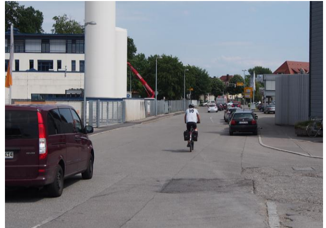
Bild 6: Die Leutholdstraße beim MTU-Schulungszentrum: Fahrbahnschäden bzw. nicht fertiggestellte Tiefbauarbeiten und parkende Pkw zwingen Radfahrer zu Slalomfahrten.
