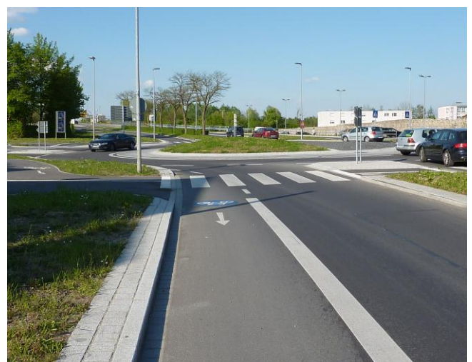
Bild 29: Auf der Nordseite der Ehlersstraße wird der Radverkehr auf einem Radfahrstreifen geführt.
