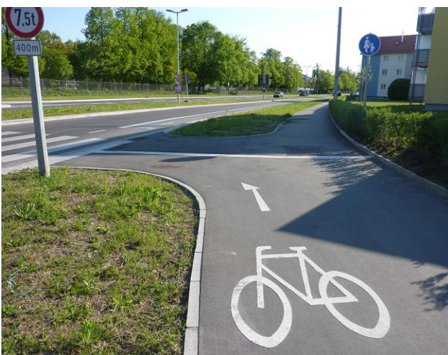
Bild 29: Auf der Nordseite der Ehlersstraße wird der Radverkehr auf einen Radfahrstreifen ausgeleitet.
