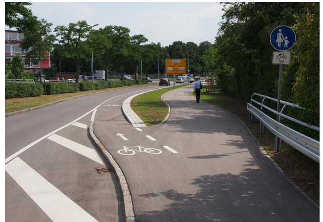
Bild 21: Auch bei der Ausleitung von der Messestraße auf die Fahrbahn kann der Radverkehr weiterhin im Seitenbereich weiterfahren. Dies ist z.B. für in Richtung Mühlöschstraße sinnvoll.
