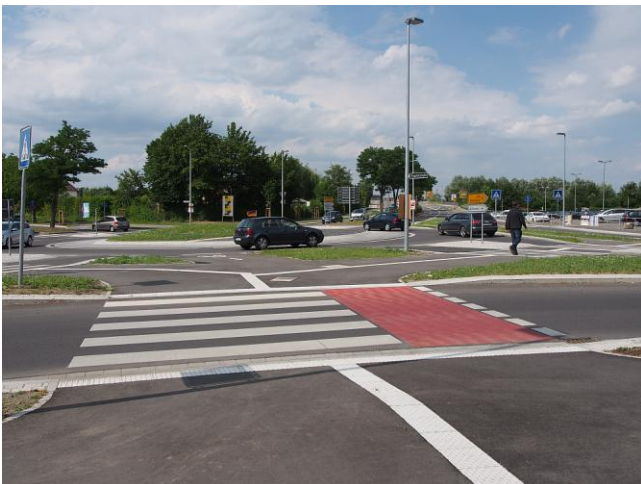
Bild 32: Bei der Überquerung des Bypasses von der Ehlersstraße zur Flugplatzstraße besteht eine neben dem Fußgängerüberweg markierte Furt für Radfahrer. Diese Furt dürfen Radfahrer bevorrechtigt befahren.
