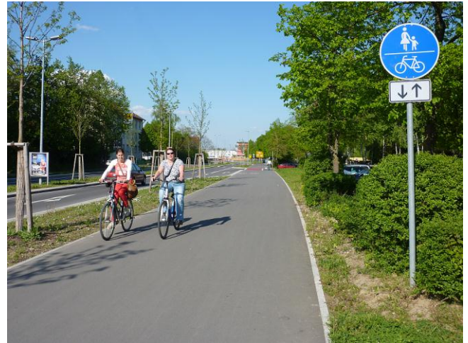
Bild 31: Der gegenläufige Geh- und Radweg an der Ehlersstraße entlang der ZF ermöglicht mit 4,2 Metern Breite eine konfliktfreie Benutzung für Radfahrer und Fußgänger im Beidrichungsverkehr.
