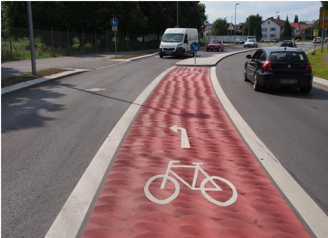
Bild 24: Auf der Flugplatzstraße wurde eine komfortable Abbiegespur für Radfahrer markiert, die auf den linksseitigen Radweg an der Ehlersstraße fahren möchten.
