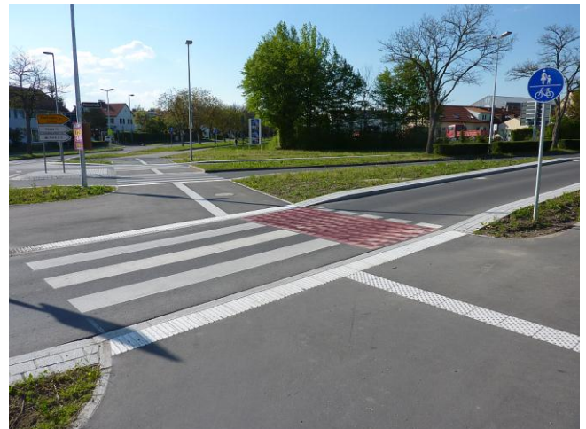
Bild 33: Auch über den Bypass von der Flugplatzstraße zur Messestraße wurde eine Radfurt markiert. Dass bei den Querungen der Kreisverkehrszufahrten keine Radfurten markiert sind, entspricht zwar den Vorschriften. Es ist aber für viele Verkehrsteilnehmer nicht nachvollziehbar, dass direkt hintereinander folgend zwei unterschiedliche Situationen mit unterschiedlichen Vorfahrtsrechten existieren.
