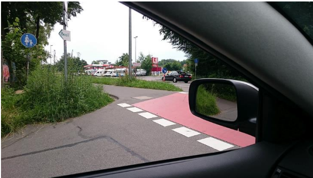
Bild 7: Fehlende Sichtbeziehung auf den Radweg an der B31 beim Halten vor der Radfurt.
