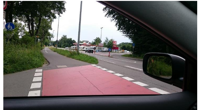
Bild 8: Eine Sichtbeziehung ist für Kfz-Fahrer nur durch Halten auf der Radfurt möglich.
