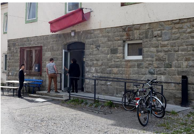
Bild 3: Gebäude Fallenbrunnen 18: Auch hier sind die vorhandenen Fahrradparker suboptimal.
