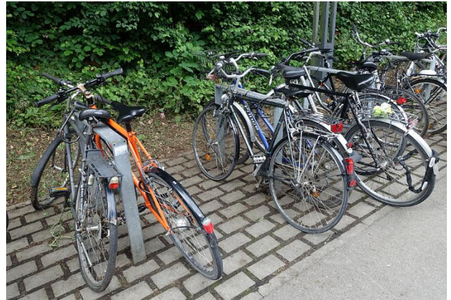
Bild 5: Die Abstände zwischen den vorhandenen Anlehnbügeln sind zu groß, dadurch werden (auch wegen des zu geringen Angebots) weitere Räder dazwischen gestellt. Anlehnbügel führen grundsätzlich zu einem unordentlichen Bild der abgestellten Fahrräder. Die scharfkantigen Bügel können außerdem zu Schäden am Rahmen führen.
