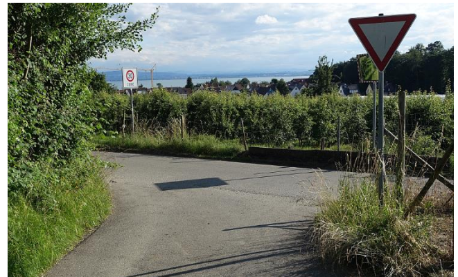
Bild 10: Trotz vorhandenem Spiegel ist die Einmündung des Weges von der Windhager Straße zur Glärnischstraße unübersichtlich.
