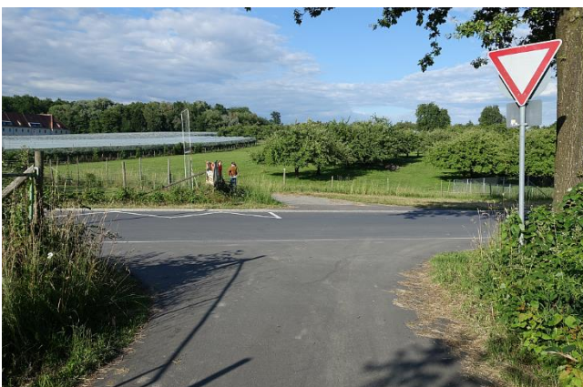
Bild 11: Die Einmündung des Verbindungsweges von der Windhager Straße in die Glärnischstraße ist unklar (Haltelinie).
