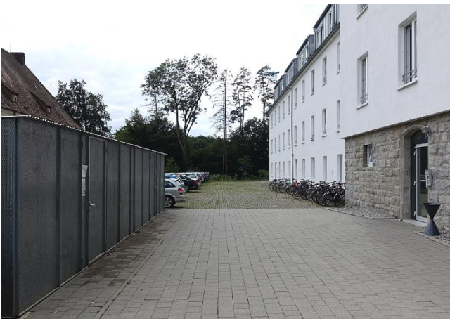
Bild 1: Gebäude Fallenbrunnen 19: Überdachte Abstellanlage für Mülltonnen (links), nicht überdachte Fahrradabstellanlage (rechts).
